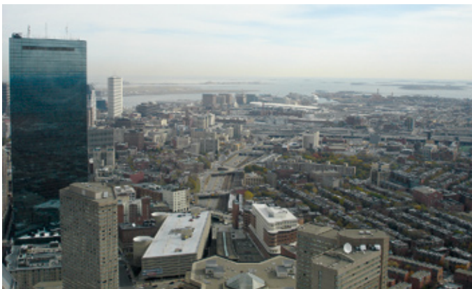
Gutes Pflaster für Aufsteiger: Boston
